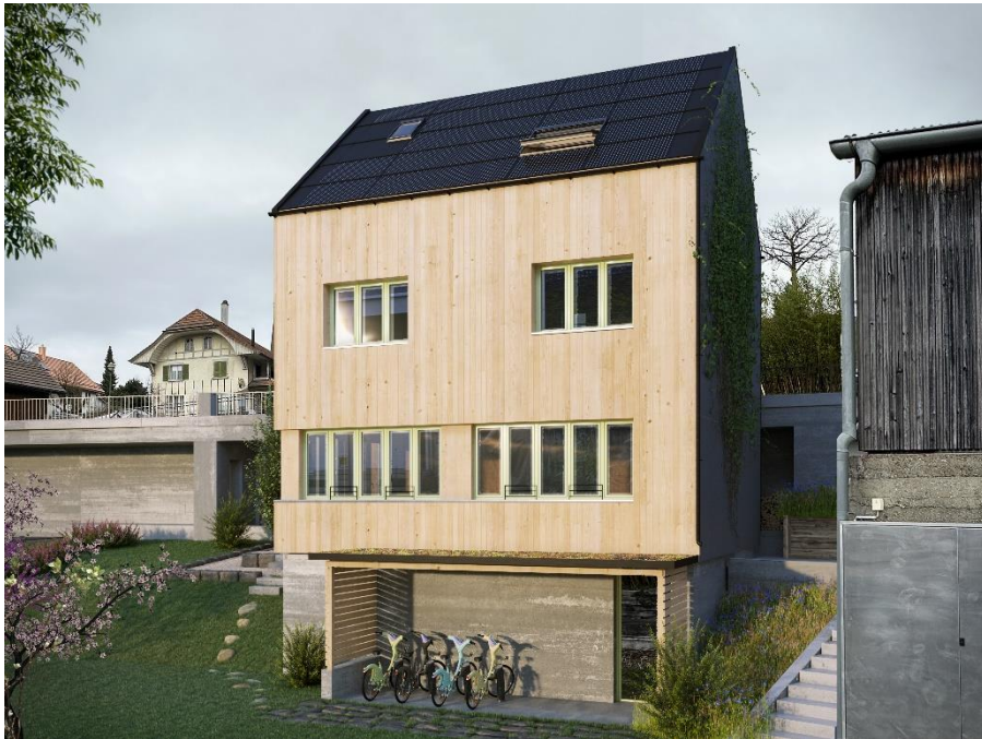
Südseite mit Velounterstand und Kellereingang
