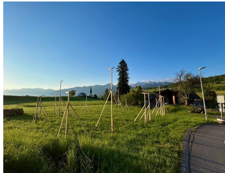
Bauprofile auf der Parzelle
